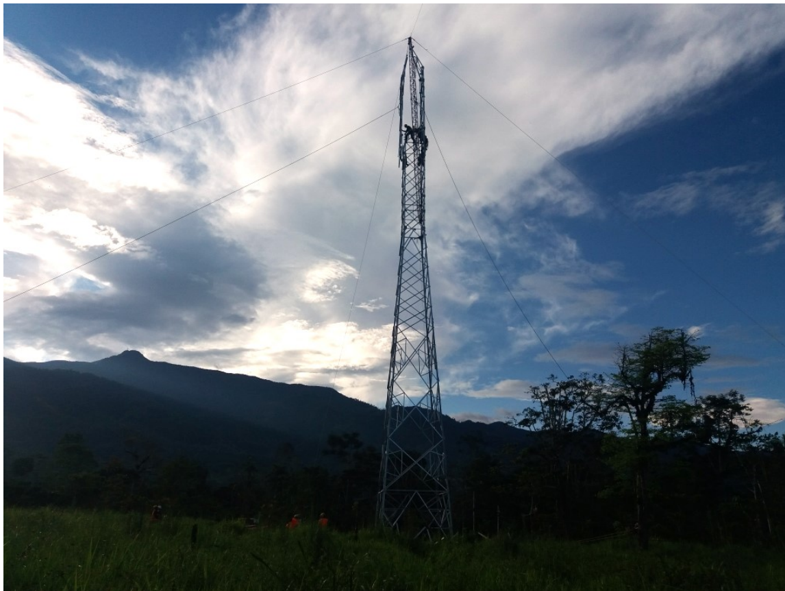
Figura 5. La construcción de la Línea de Transmisión Eléctrica continua en tres frentes de trabajo
